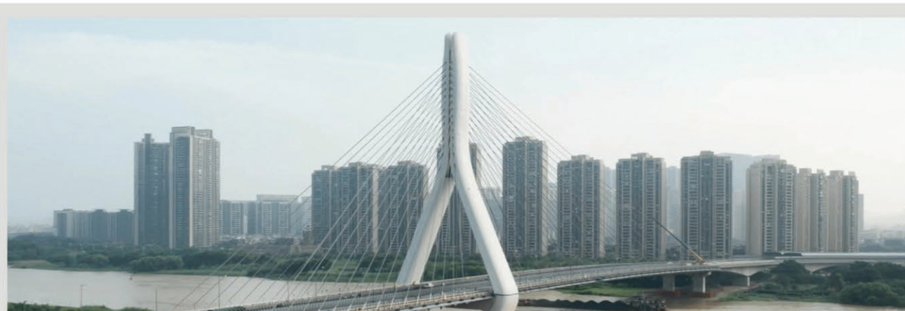
佛山同济大桥
