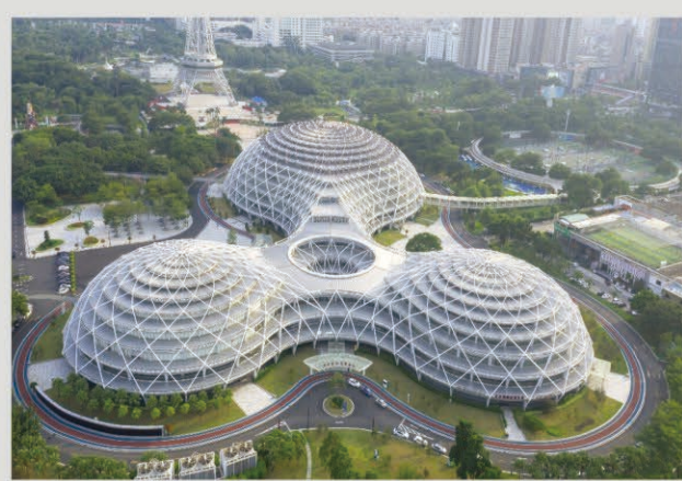
佛山岭南明珠体育馆
